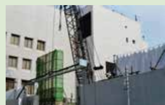
工事現場の安全管理 熱中症の予防・風速の監視
